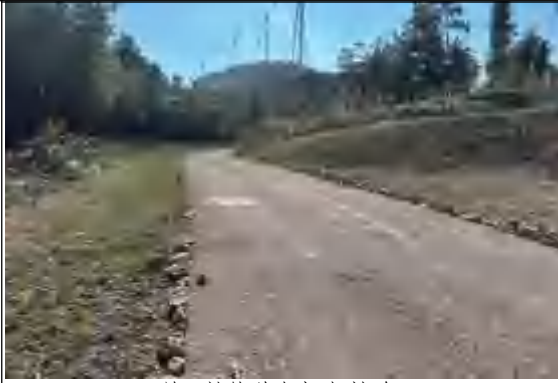
施工检修道路生态恢复
