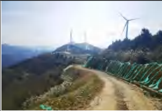
道路工程区恢复情况 8
