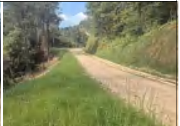
道路工程区恢复情况 5
