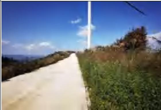
道路工程区恢复情况 10
