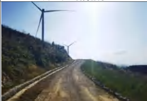
道路工程区恢复情况 6
