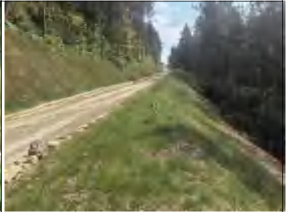
道路工程区恢复情况 3
