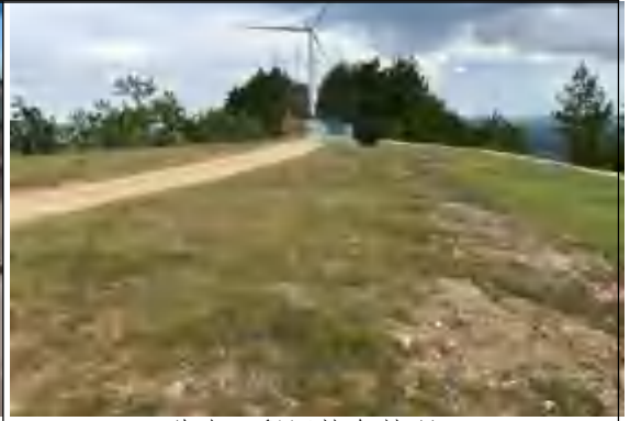
道路工程区恢复情况 1
