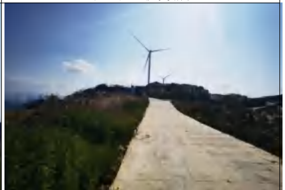
道路工程区恢复情况 7
