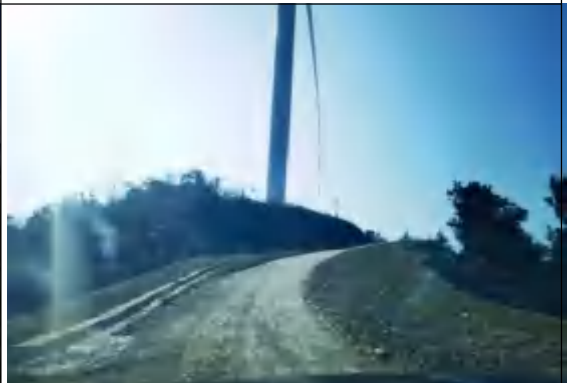
道路工程区恢复情况 11
