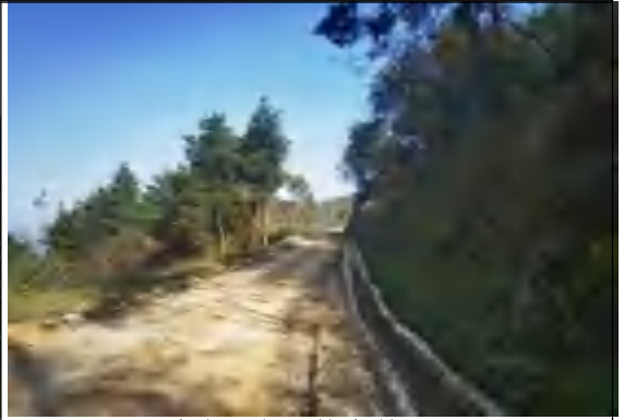
道路工程区恢复情况 9
