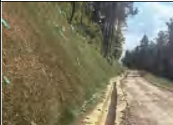
道路工程区恢复情况 4
