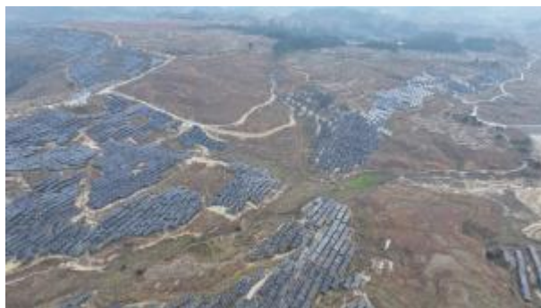
四号地块光伏区现状图 2
