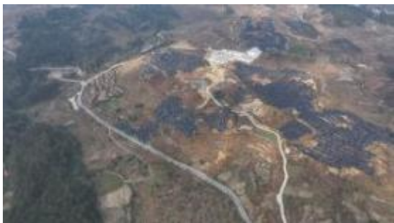
三号地块光伏区现状图 1（环评中五号地块实际使用区域）
