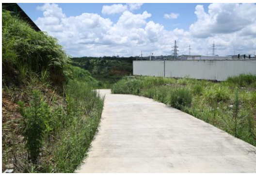
升压站周边道路 1
