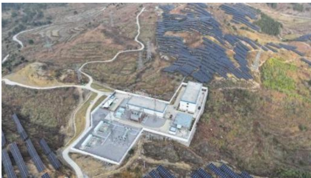
甲良升压站现状图
