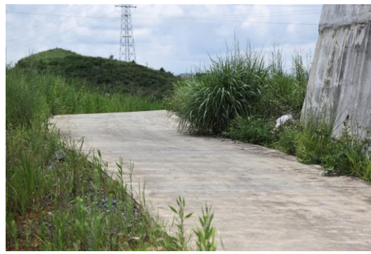
升压站周边道路 2
