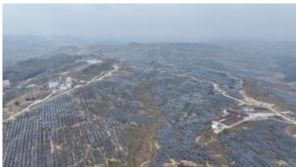
四号地块光伏区现状图 1
