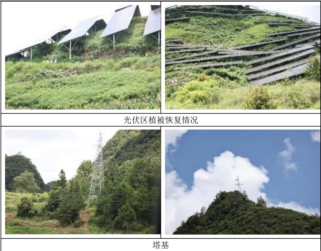
图 6 光伏区及塔基植被恢复情况图
