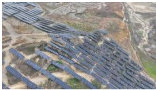
三号地块光伏区现状图 2（环评中五号地块实际使用区域）
