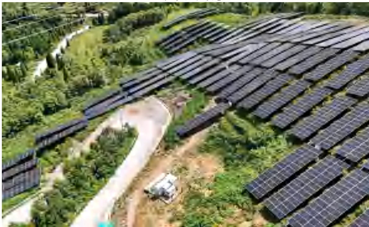
光伏区现状③
