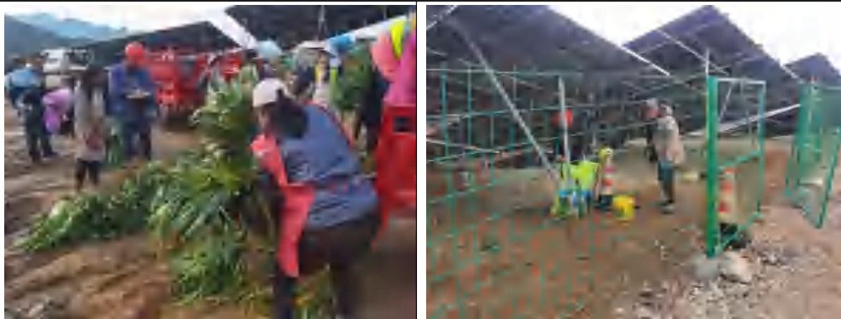
施工现场播撒草种及光伏板下绿植种植
