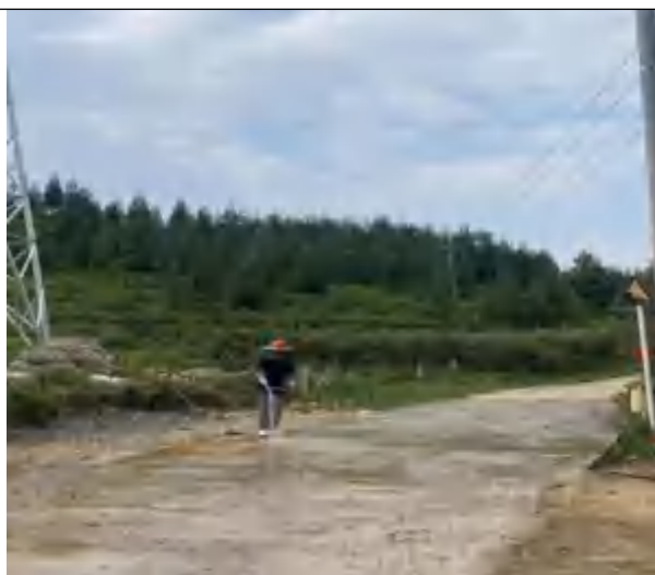
施工区域洒水降尘
