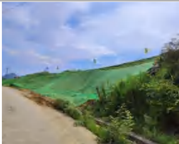
施工期临时覆盖
