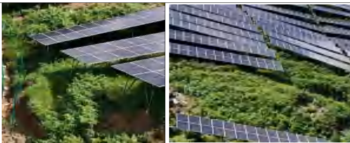
光伏场区植被恢复情况
