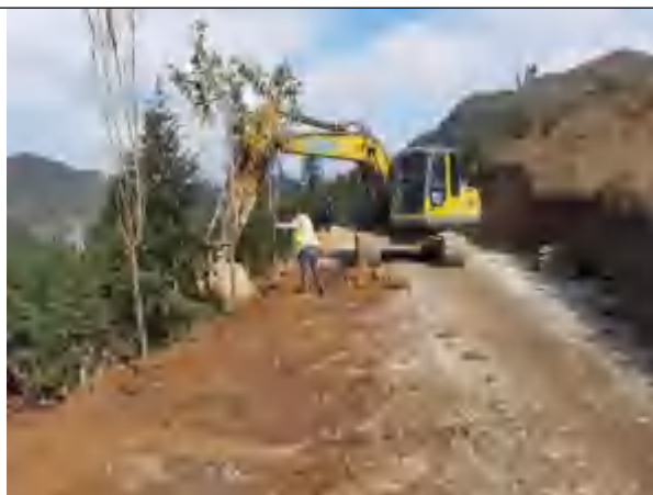
施工道路覆土恢复
