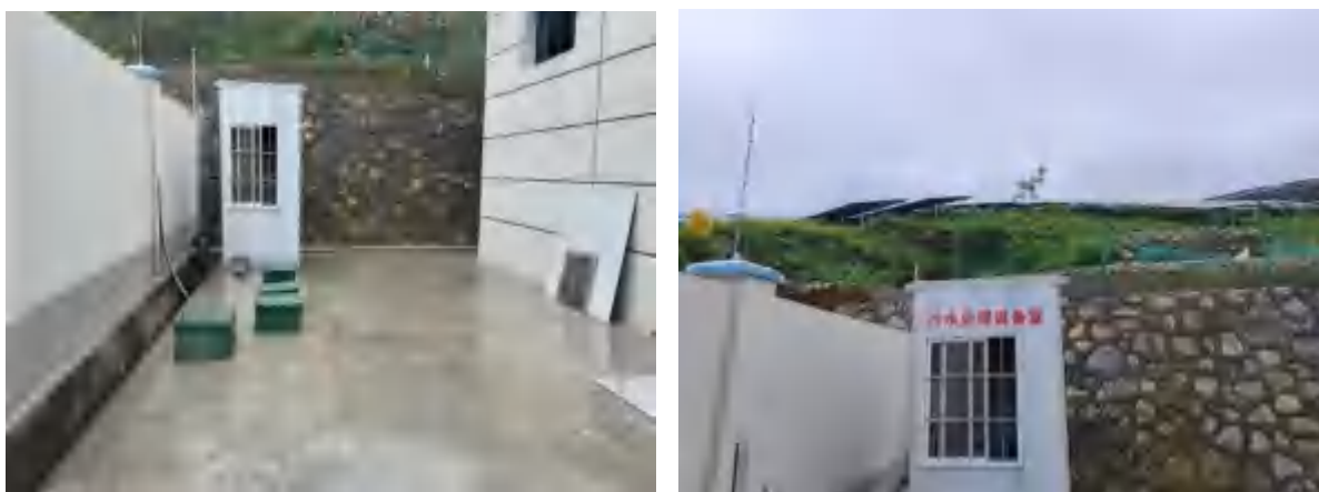
图 6-3 污水处理一体化设备
