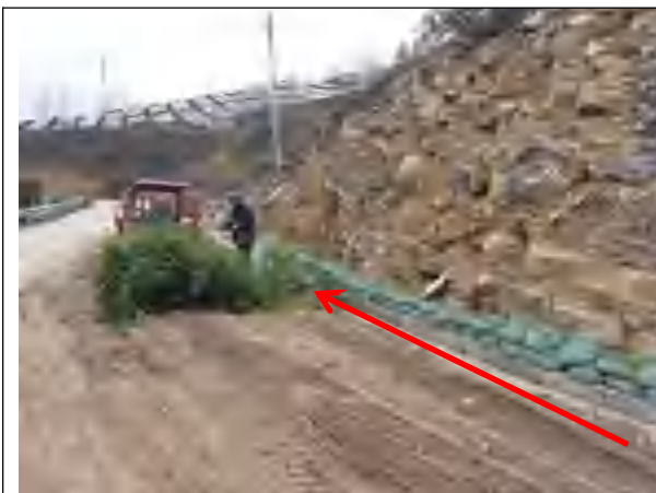
施工区道路排水沟
