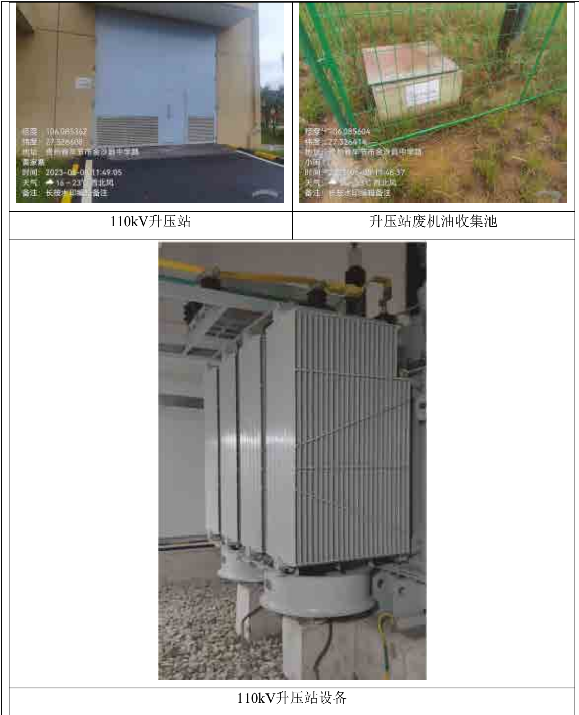
图4-2 110kV升压站现场环境照片
