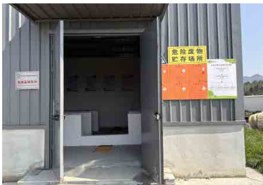
图 4-7 垃圾焚烧厂危废暂存间
