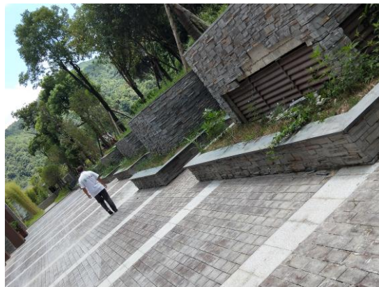
地下停车场排气口
