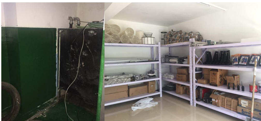
危险废物及柴油库
