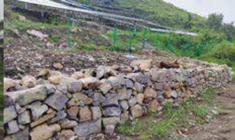
光伏阵列区已实施的干砌石拦挡 2
