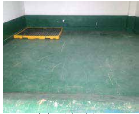
危废暂存间照片 2
