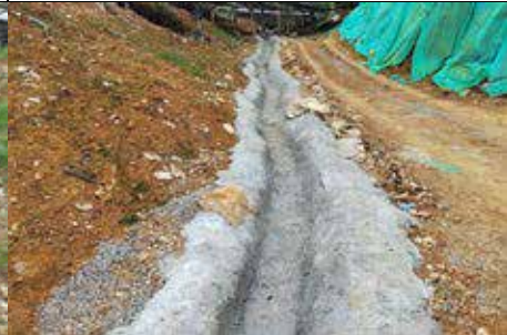
光伏阵列区已实施的排水沟 2
