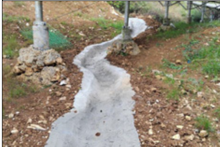
光伏阵列区已实施的排水沟 1
