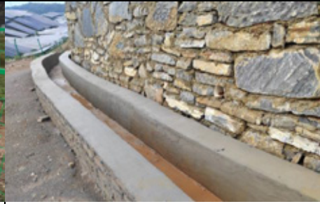
道路工程区已实施的排水沟 2
