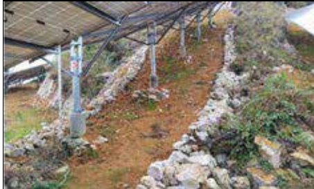
光伏阵列区已实施的干砌石拦挡 3
