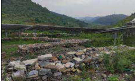
光伏阵列区已实施的干砌石拦挡 1
