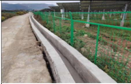
道路工程区已实施的排水沟 1
