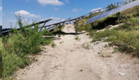
场内预留检修道路
