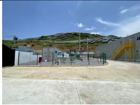
升压站地面硬化
