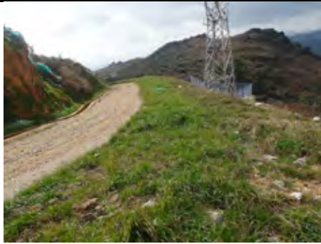
边坡绿化及排水沟
