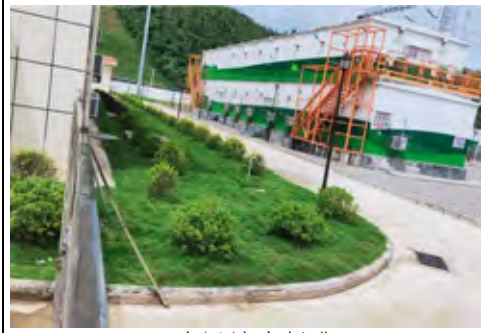
升压站内绿化
