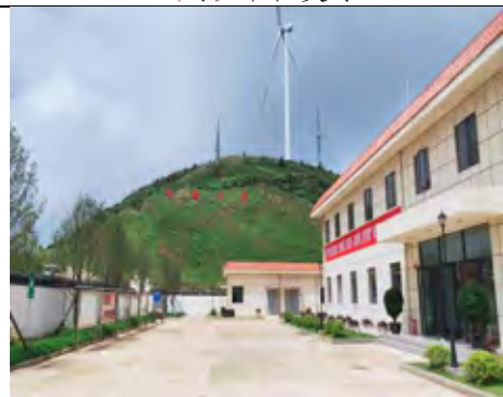
升压站内绿化
