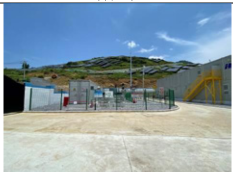
升压站地面硬化
