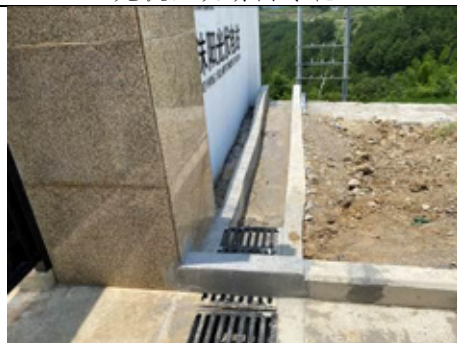
升压站截排水沟
