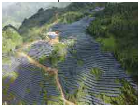
光伏阵列及开关站
