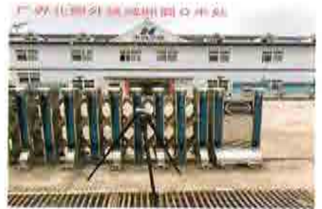
N22#升压站衰减断面北侧 0m 处
