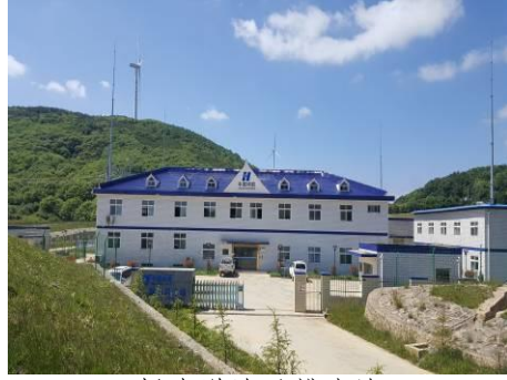
场内道路及排水沟
