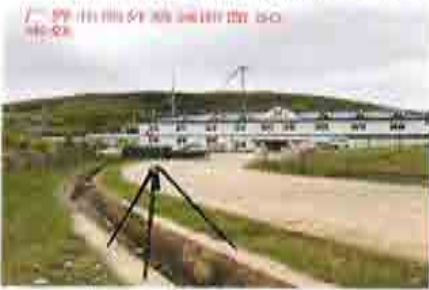
N23#升压站衰减断面北侧 50m 处
