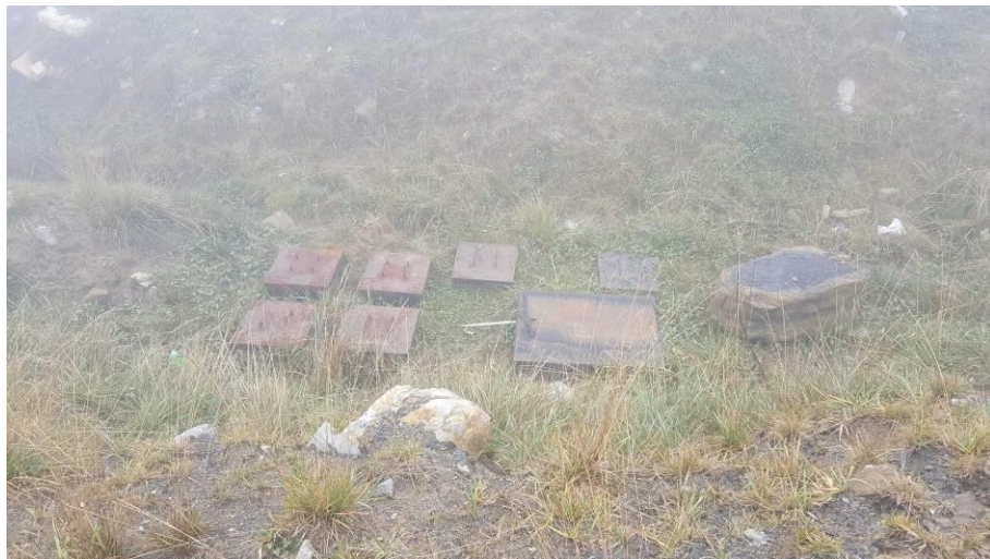
生活污水处理设施
