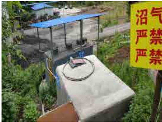
化粪池及生活污水处理站
