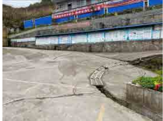
地面硬化及排水沟
