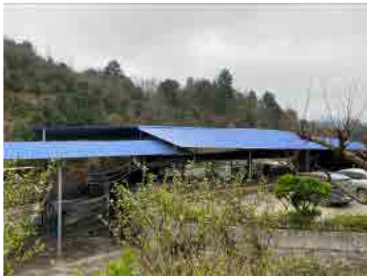
半封闭储矿场
