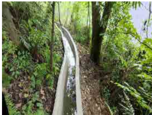
废石场环场截排水沟
