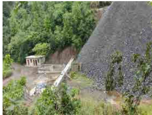
废石场挡墙及淋溶水收集池
