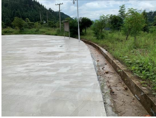
进库公路及排水沟
