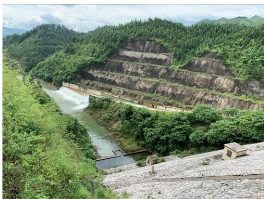
坝下右岸护坡
