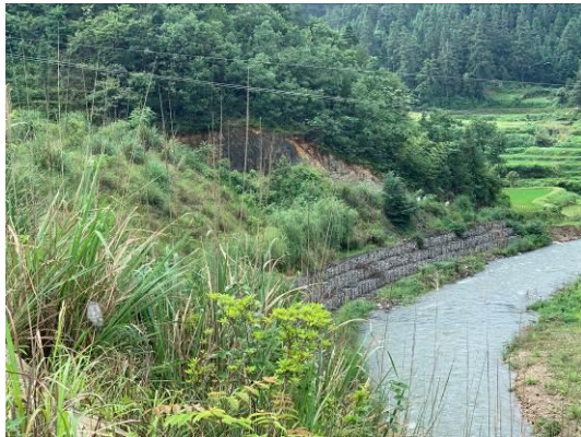
2#弃渣场挡渣墙及坝下河道
