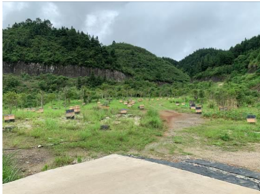
弃渣场植被恢复
