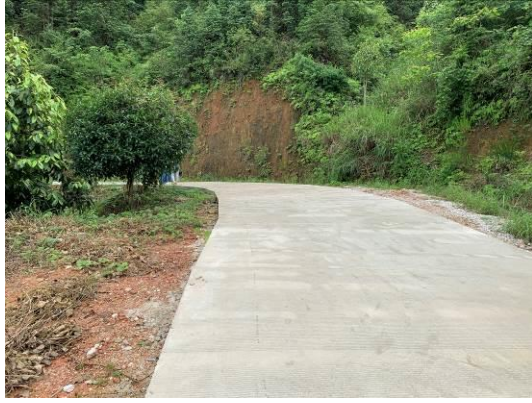
库内水泥硬化公路
