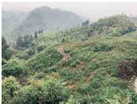
7#弃渣场植被恢复现状级排水沟
