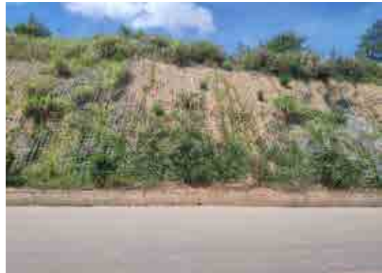
护坡及排水沟
