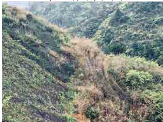
4#弃渣场植被恢复现状及挡土墙
