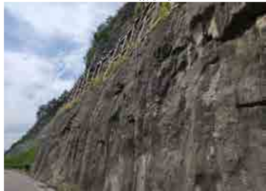
喷浆边坡、排水沟
