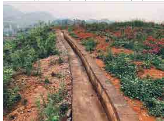
3#弃渣场排水沟
