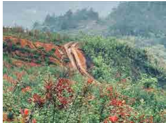
3#弃渣场植被恢复现状及排水沟
