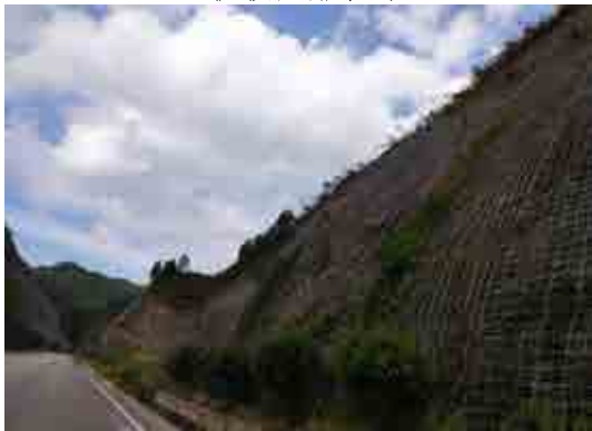
护坡及排水沟
