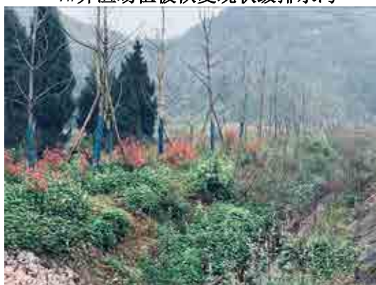
9#弃渣场植被恢复现状及排水沟
