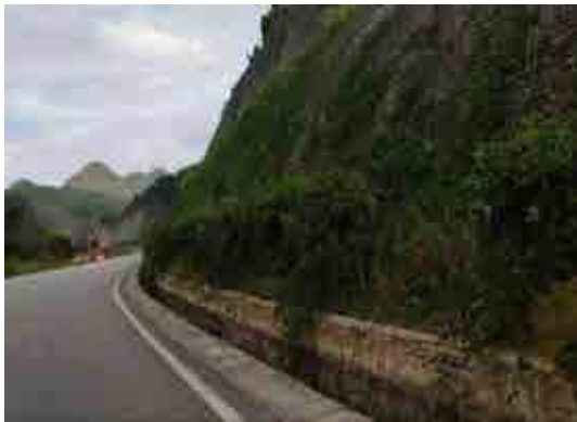
护坡及排水沟
