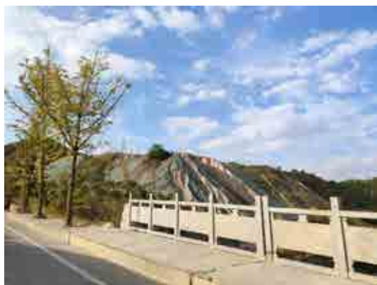
2#弃渣场植被恢复
