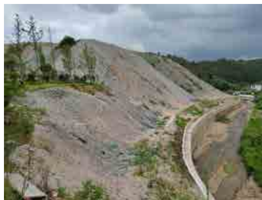
2#弃渣场挡渣墙
