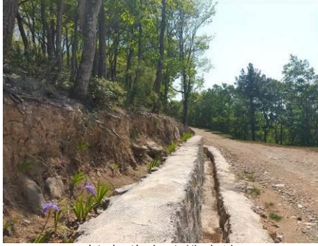
场内道路及排水沟
