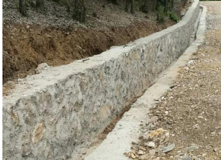
场内道路排水沟、挡土墙
