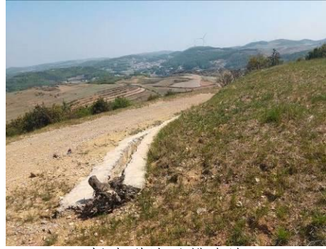
场内道路及排水沟
