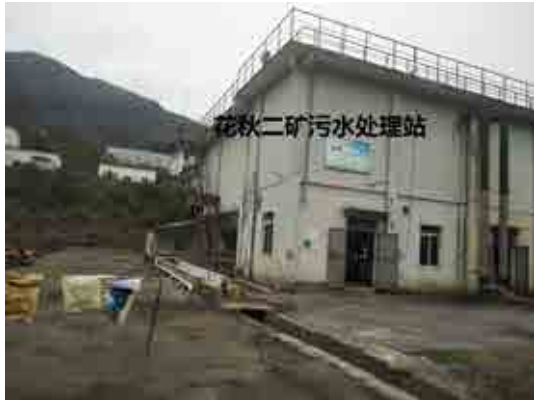
生活污水处理站
