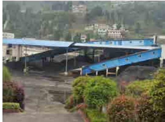
半封闭储煤场
