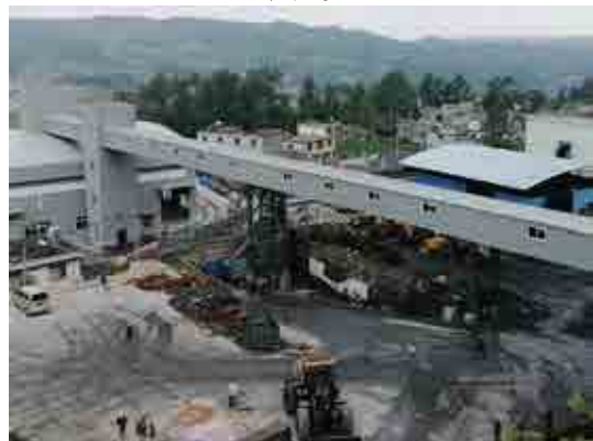
封闭式输煤栈道
