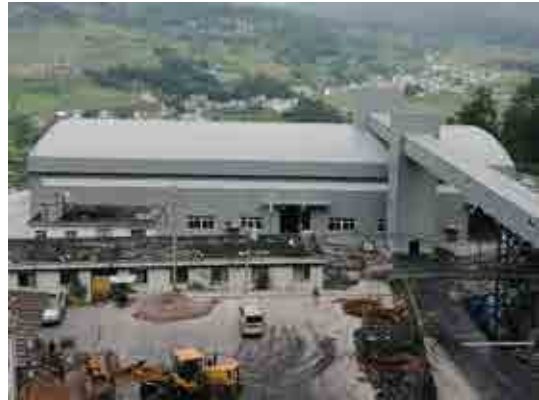
封闭式储煤场
