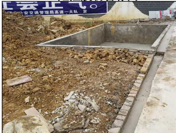
危险废物暂存间
