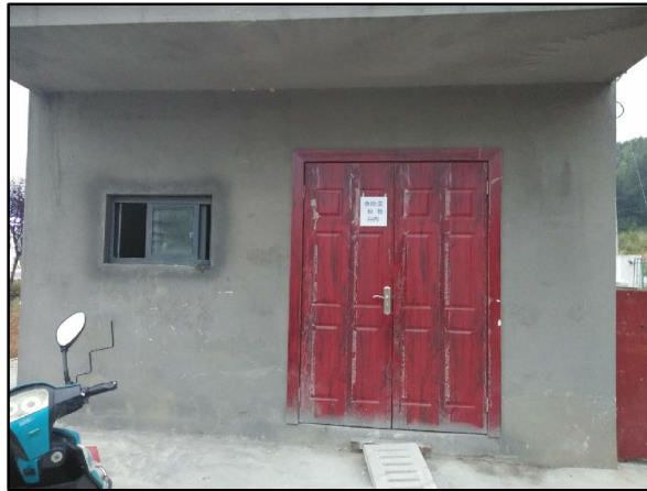
危险废物暂存间
