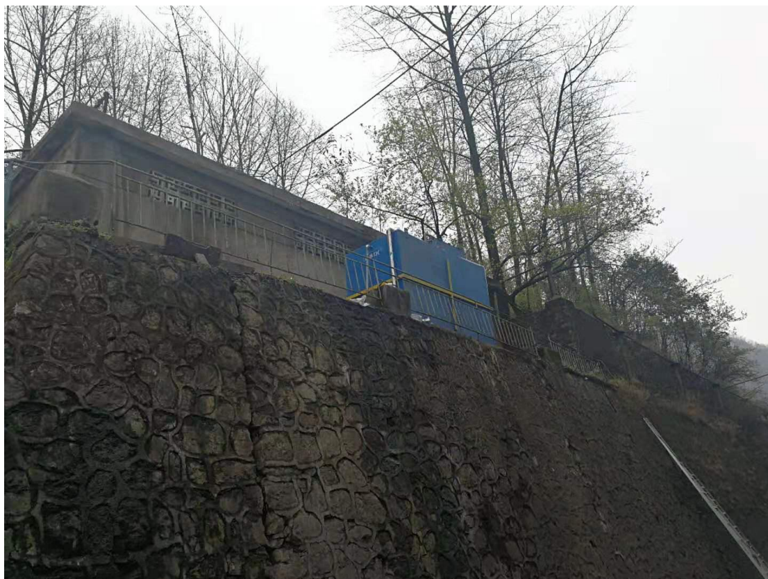
污水处理设施
