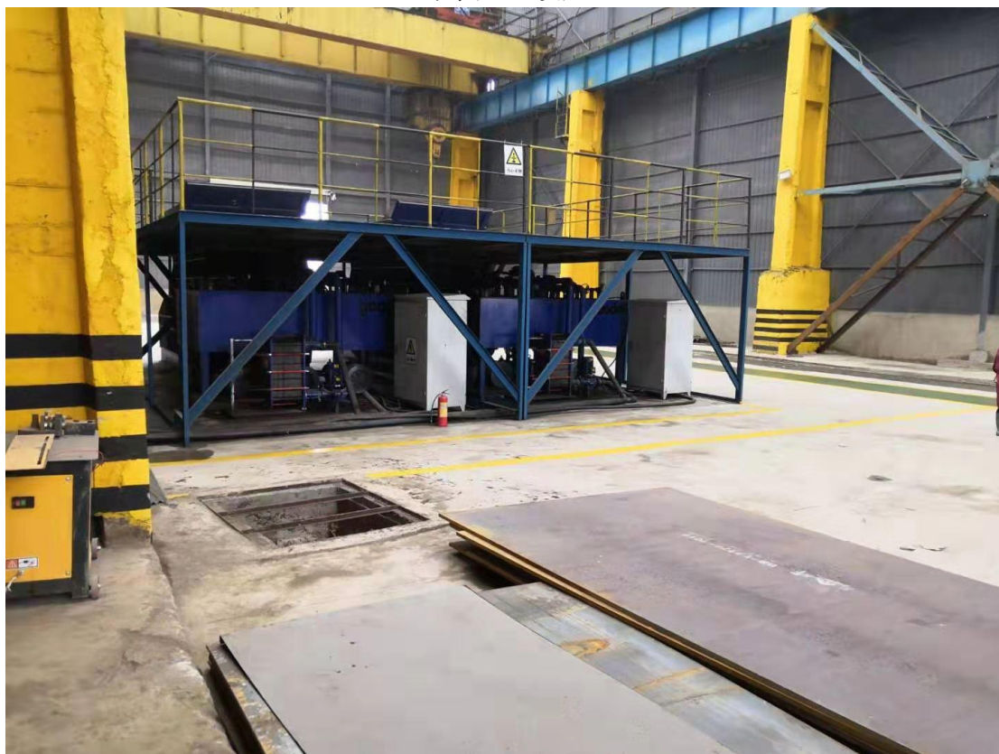
场地冲洗沉淀池
